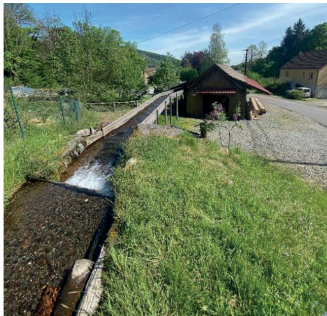
L'aménée d'eau qui fait tourner la roue à augets. Photo Alain Fendeler
