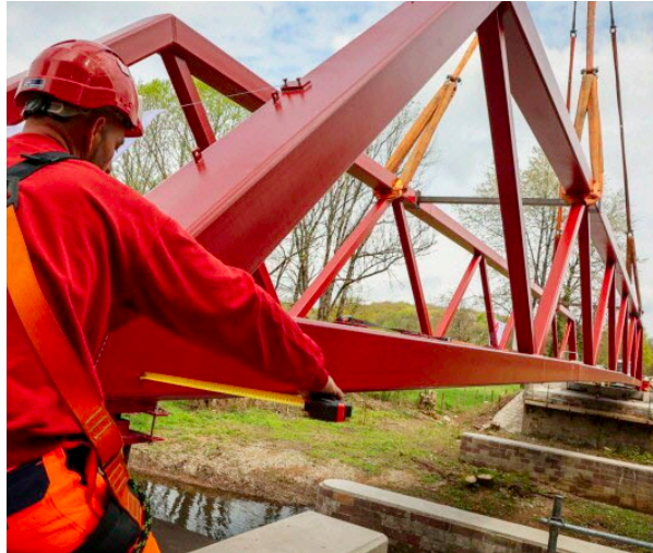
La mise en place de la passerelle au-dessus de la Savoureuse, pour relier la rue des Sablettes au chemin stratégique, à Sevenans, a eu lieu le 26 avril. Photo d'archives Michaël Desprez
