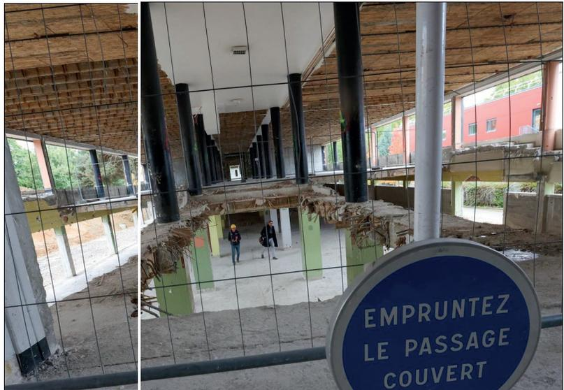
Construit en 1964, le bâtiment A de l'UTBM fait l'objet d'une rénovation radicale. Il a été entièrement déshabillé. Ne demeure à ce jour que l'ossature en béton. Photo ER/Michel DESPREZ
