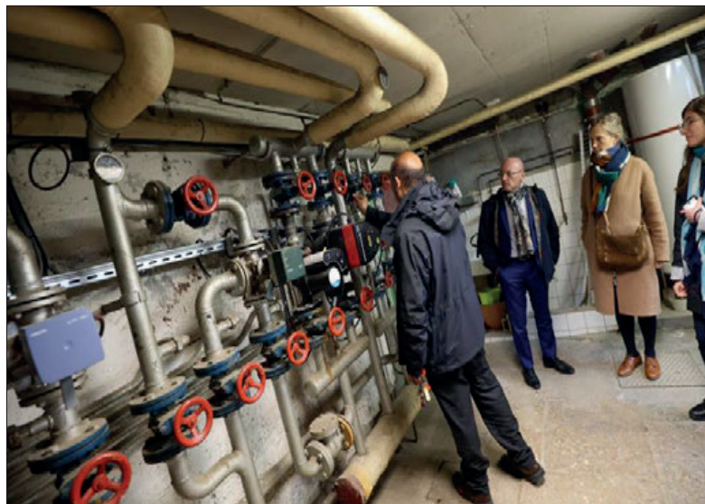
Visite dans les sous-sols de la mairie gourmande en énergie car non isolée. Photo ER/Lionel VADAM
