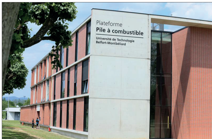
Le Nord Franche-Comté va devenir le cœur de la filière hydrogène en France. Ici, le bâtiment FC Lab de la plateforme Pile à combustible de l'UTBM, un laboratoire de recherche d'envergure européenne. Photo ER/Christine DUMAS
