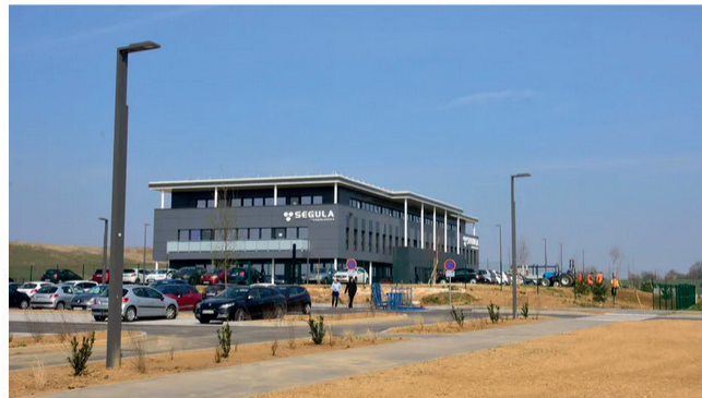
Le nouveau centre technique de Ségula Technologies à Brognard © Radio France - Christophe Beck
