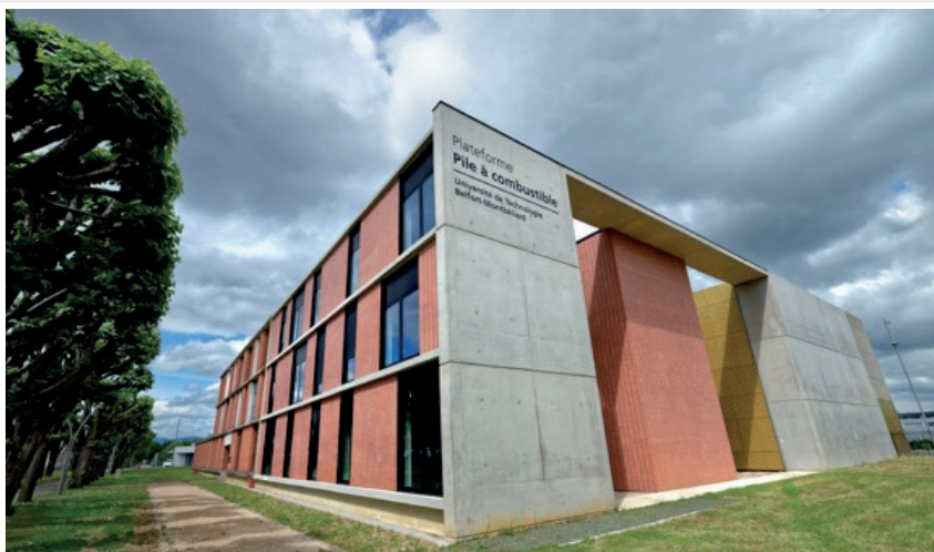
Le bâtiment qui abrite la plateforme pile à combustible, à Belfort. ©Pierre-Yves Ratti.
