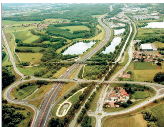
■ L'A 36 à Sévenans : des accès compliqués et dangereux. Photo DR
