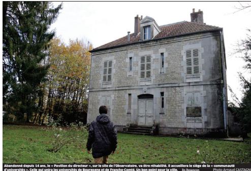
Abandonné depuis 14 ans, le « Pavillon du directeur », sur le site de l'Observatoire, va être réhabilité. Il accueillera le siège de la « communauté universitaire ». C'est qui unira les universités de Bourgogne et de Franche-Comté, un bon point pour la ville. Et Besançon. Photos Arnaud CASTAGNE
