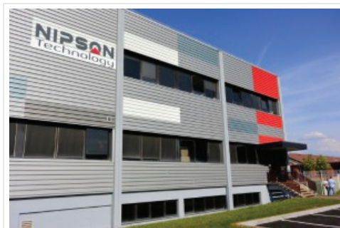
La façade du bâtiment rénové sur le Techn'hom de Belfort : l'isolation a été complètement refaite. © Pierre-Yves Ratti.
