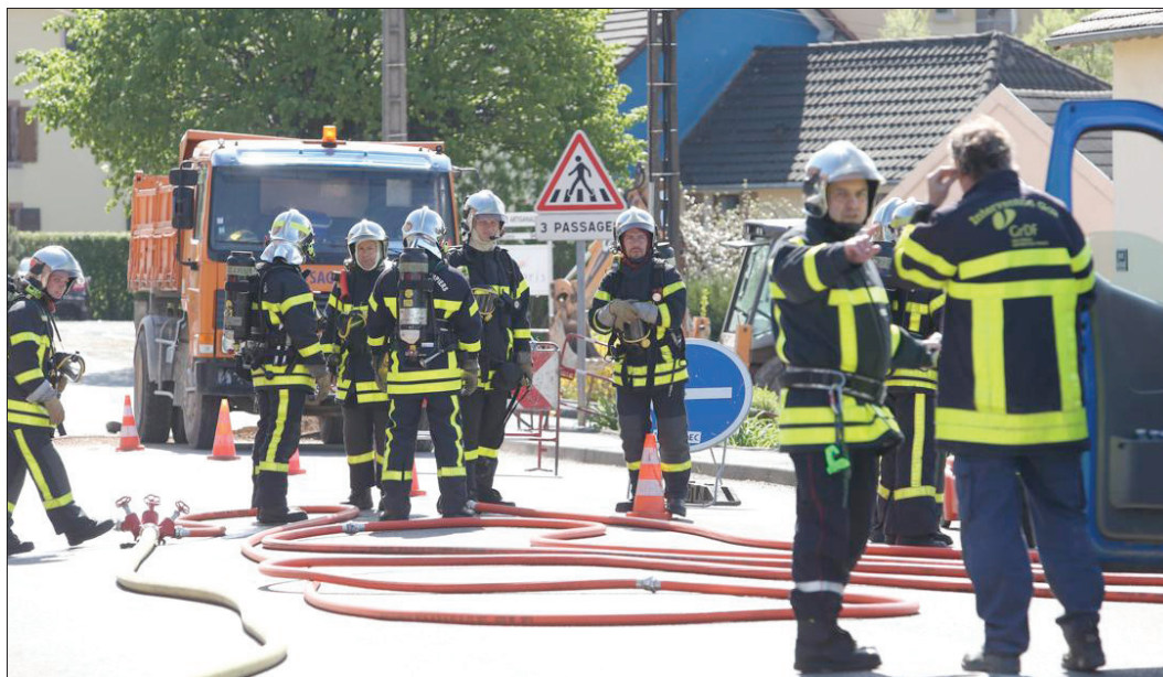
■ Une conduite de gaz a été endommagée lors des travaux hier matin mais, vers midi, les voitures pouvaient à nouveau traverser le village. Photo Lionel VADAM
