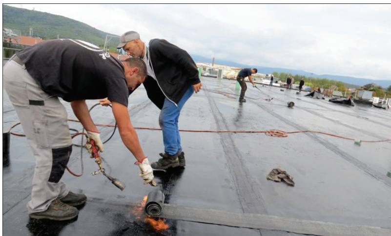
■ Débutée en mai dernier, la réfection de la toiture du bâtiment 12 du Techn'Hom (600.000 euros) est sur le point de s'achever.
