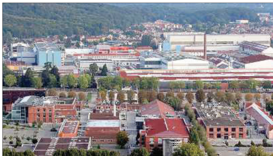
Le site industriel du Techn'hom va subir une série d'aménagements ayant pour but de renforcer son attractivité. Photo archives Jean Becker
