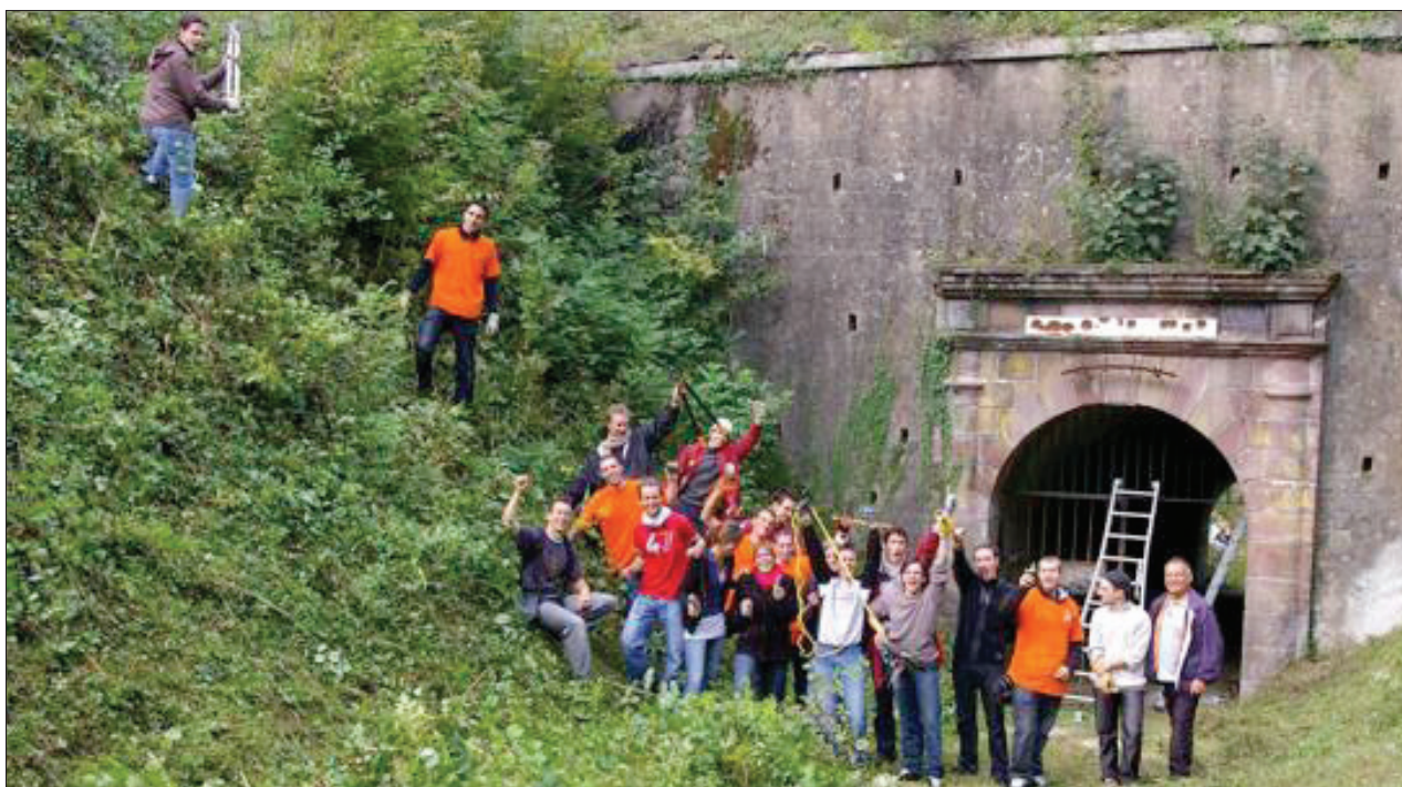
Les Amis du fort d'Essert reçoivent presque chaque année le renfort des étudiants de l'UTBM pour défricher les parois de l'enceinte fortifiée.
