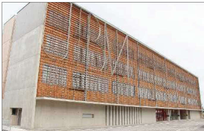
650 000 euros du FEDER ont été investis dans le bâtiment EDIM (Ergonomie, design et ingénierie mécanique) de l'UTBM à Montbéliard. Photos Jacques Balthazard
